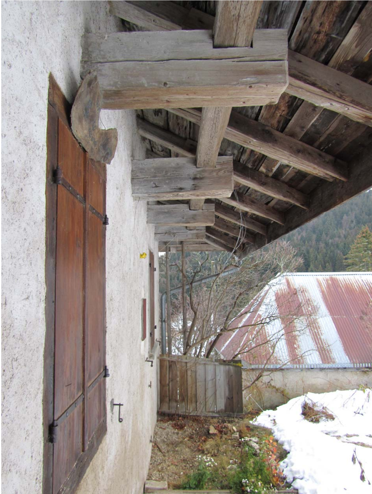
Bel avant-toit de la façade du levant. En contre-bas l'antique annexe que l'on a déjà pu remarquer sur la photo d'Auguste Reymond. Elle aussi était couverte de tavillons avant d'accueillir les tôles ainsi que le bâtiment principal. Ce toit à quatre pans est typique de certains chalets d'autres zones alpestres de notre région.
